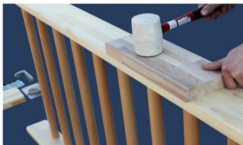
4. Egy fadarab és egy kalapács segítségével helyezze a bordákat végső helyzetükbe a két oldalal között
