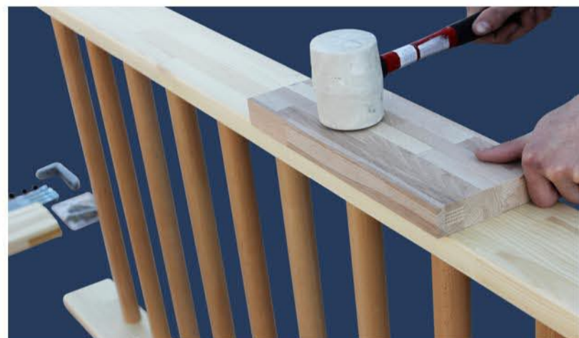
4. Pour protéger l'espalier, utiliser un bloc de bois et un marteau en caoutchouc pour insérer entièrement les barreaux dans les panneaux.
