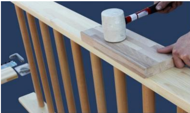
3. Fixer le second montant sur les barreaux.
