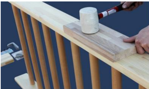
3. Das zweite Seitenteil auf die Sprossen aufstecken. Die Wangen ganz auf die Sprossen klopfen. Zum Schutz, Sprossenwand mit Holzstück und Gummihammer behandeln.
